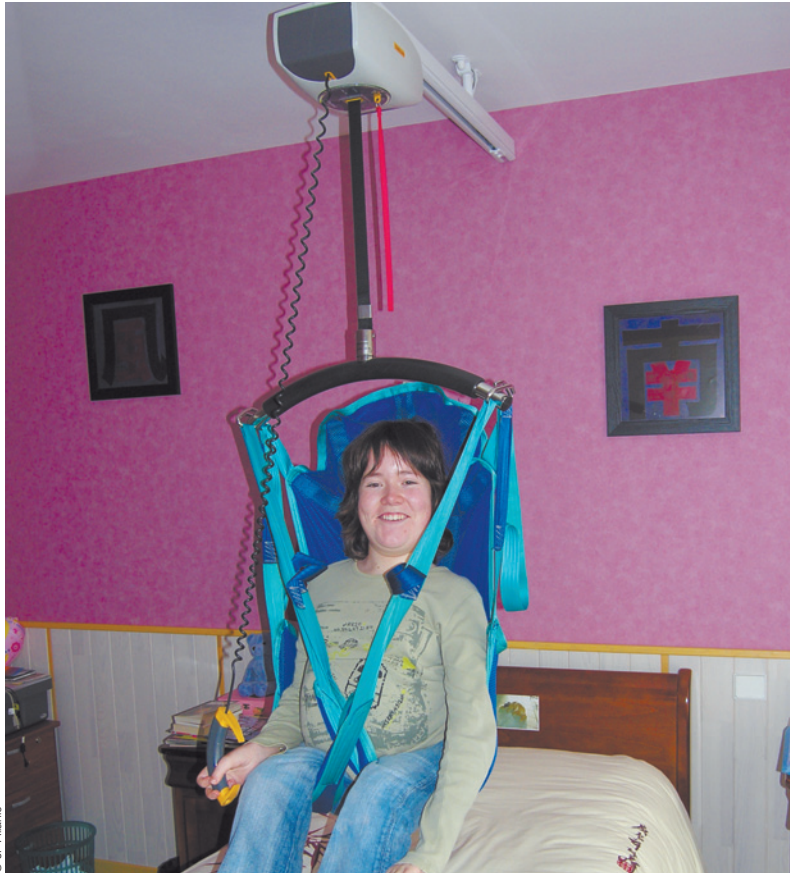
Le lève-personne installé sur des rails au plafond libère la place au sol tout en apportant une bonne sécurité.
