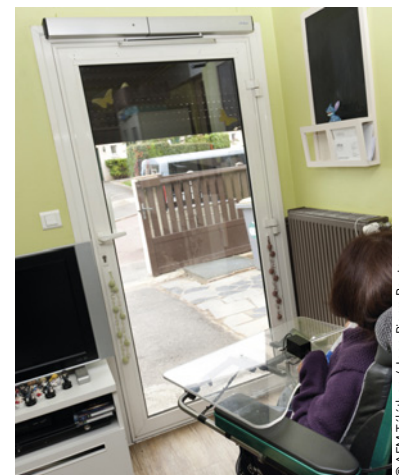
Stores, portes d'entrée ou intérieures... : les ouvrants peuvent être actionnés grâce à la téléthèse.
